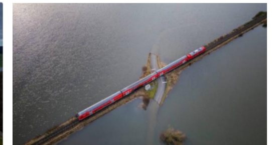
Ein Regionalbahn fährt auf einem Schienendamm der komplett von Wasser eingeschlossen ist. Die Bahnverbindung nach Eichen ist höher gelegen und bleibt in Betrieb. Quelle: Andreas Arnold/dpa
